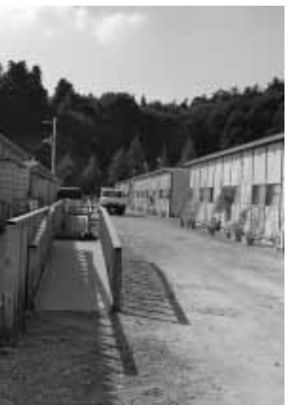
二本松市安達運動公園に建てられた応急仮設住宅(250世帯の方が生活)
