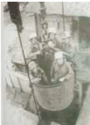
三井山野第一堅坑の掘削風景
