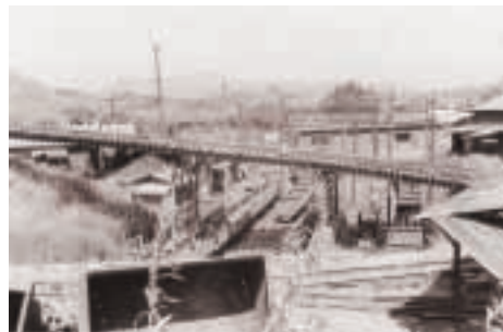
実箱を運ぶ棧橋
