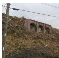
現在も残る巻き上げ機の台座
