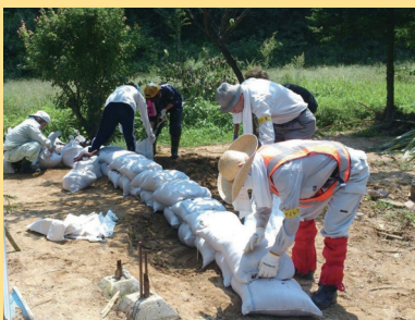
土砂の流入を防ぐため土のうを積み上げていく
