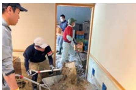
手分けして室内に入った土砂を掻き出し、運搬するボランティア
