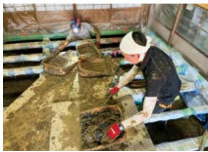
床下に入った土砂をてみで引き上げるボランティア
