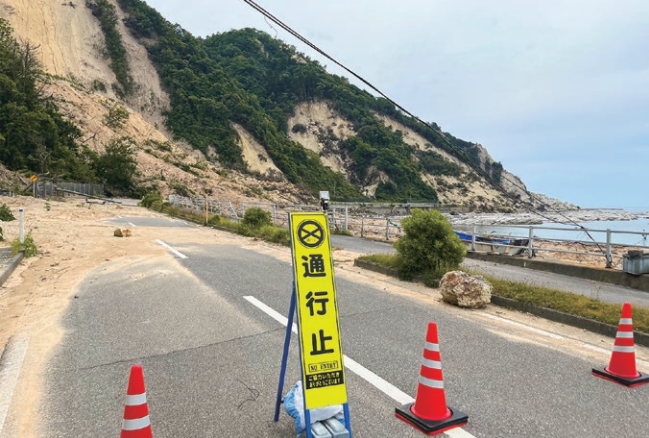
能登半島の北岸を通り、珠洲市仁江町から西隣の輪島市へ向かう国道249号線は土砂災害の影響で通行止めとなっていた
